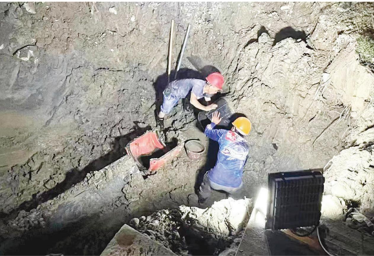
日前，卢浮郡泵站出水压力管出现长达1.7米的裂缝。市排水公司立即组织抢修，顺利修复破损管段，避免了污水外溢的情况。
