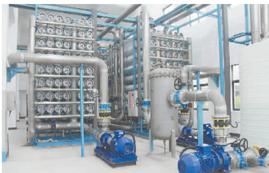
图为反渗透设备，可去除水中98%以上的盐分和绝大部分杂质。
