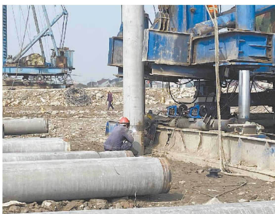
姚北水厂新建工程（一期）总投资2.4亿元，以浙江省现代化水厂标准设计和建设，2022年计划完成年度投资9600万元，预计12月底完成建筑主体及基础工程，并开始设备安装。目前，桩基施工阶段已顺利完工。
